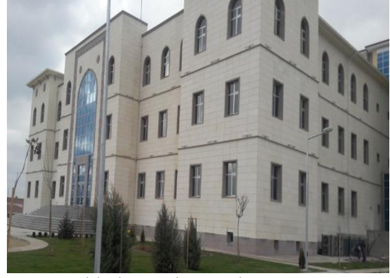
Kırıkkale Merkez Hükümet Konağı
